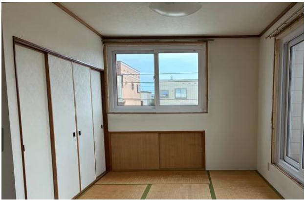
和室を洋室に変更。天井は1階和室と同様に天井下地、グラスウールを施工した後にリプラスボードを施工。壁は既存仕上げ材の上からリプラスボードを施工。壁掛けTVを設置する壁には、クロス下地合板付きのリプラスボードを施工。
